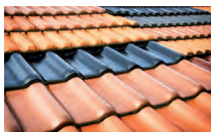
Dak- en Gevelbedekking
